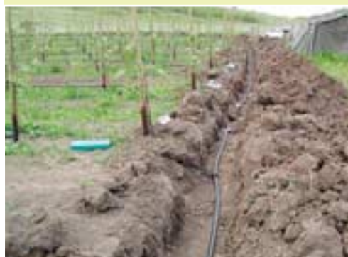
Das Bewässerungssystem wird verlegt.
