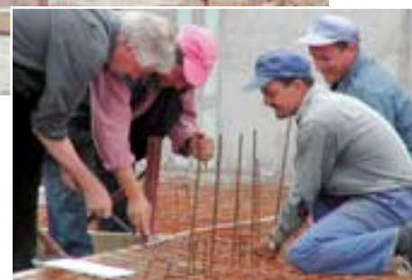
Die Fundamente und Keller der ersten Wohnhäuser stehen bereits.
